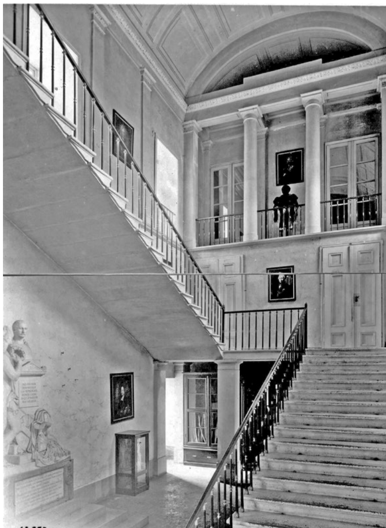
Schodišťová hala, 1948, zdroj: Národní památkový ústav
