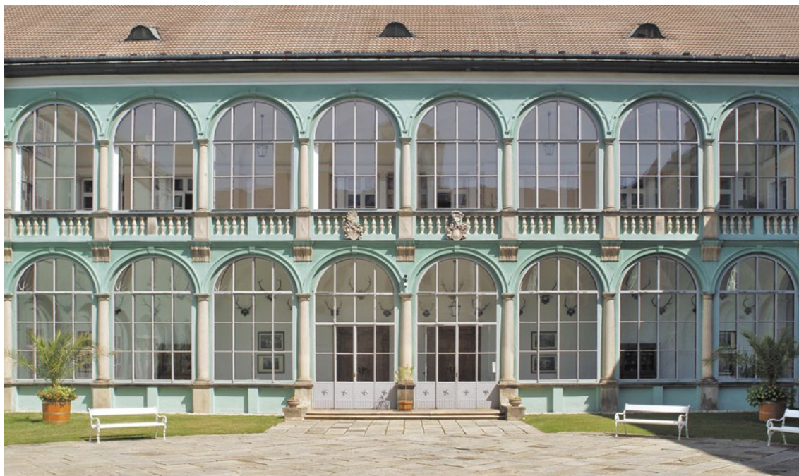
Renesanční arkády severního křídla, foto Aleš Motejl
